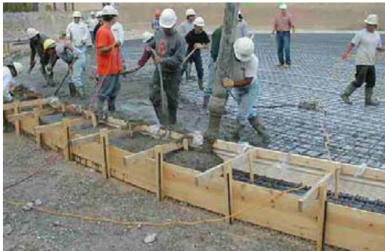
ਤਸਵੀਰ 2.14: ਦੁਬਾਰਾ ਪੱਕਾ ਕੀਤਾ ਸੀਮਿੰਟ-ਕੰਕਰੀਟ (Reinforced cement concrete/RCC)
